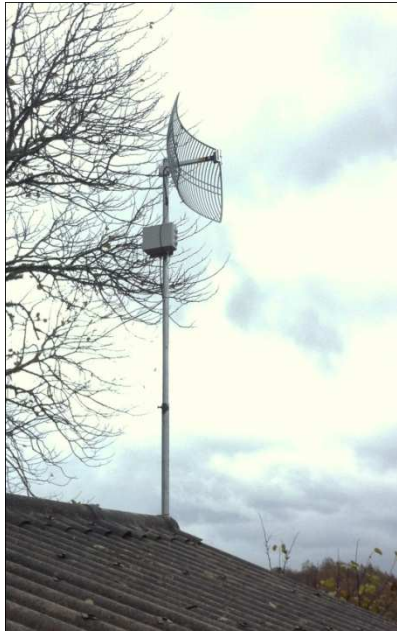
Εικόνα 3: Εγκατάσταση στο σημείο A (αποθήκη)
