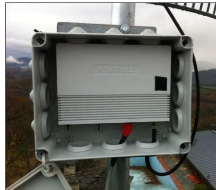
Εικόνα 4: Στεγανό κουτί στο σημείο B (σπίτι)
